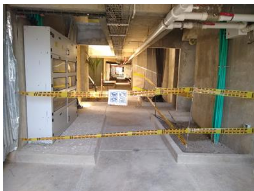
Fotografía – Señalización de uso de EPP en obra Fuente: Torres de Sevilla
